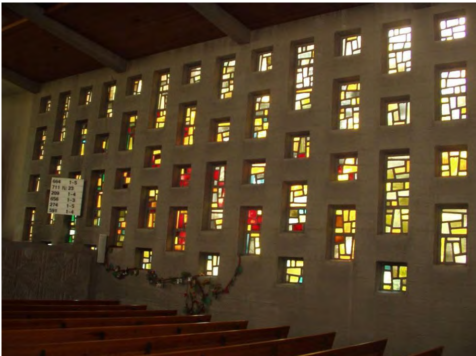
Abbildung 5 Buntgetönte Fenster an der Südseite
