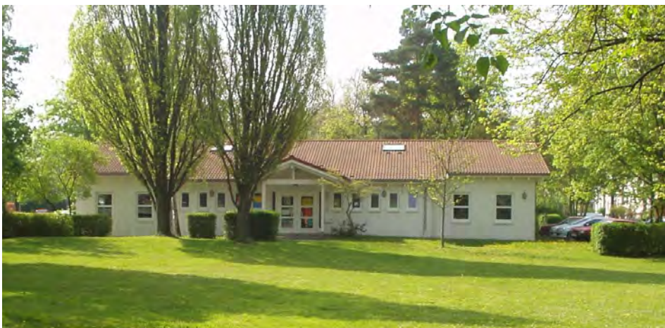
Abbildung 1 Kindergarten Neubau Nordseite
