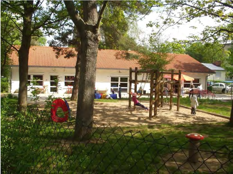
Abbildung 2 Kindergarten Neubau Südseite
